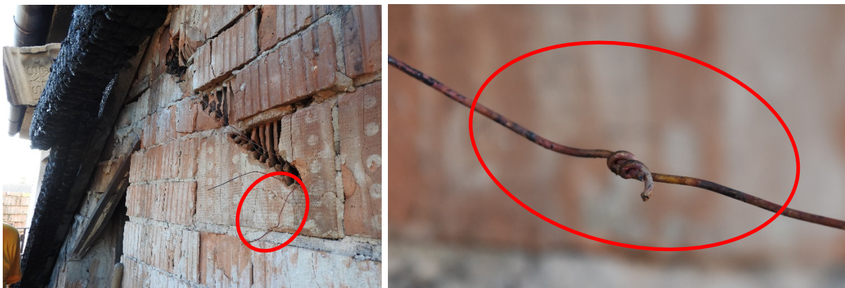
Obr. 3-4 – pohľad na realizované pripojenie nového osvetlenia k pôvodnej elektrickej inštalácii.
