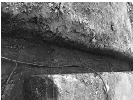
Obr. 1 Fotozáznam z prehliadky uzemňovača pred zaliatím základov. Na obrázku nie sú vyhotovené dištančné podpery, vhodná protikorózna ochrana a ďalšie nedostatky.
