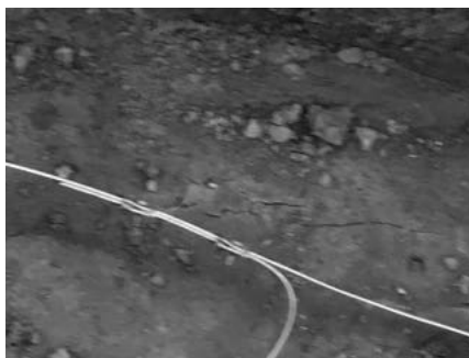
Obr. 1 Fotozáznam z prehliadky uzemňovača pred zaliatím základov. Na obrázku nie sú vyhotovené dištančné podpery, vhodná protikorózna ochrana a ďalšie nedostatky.
